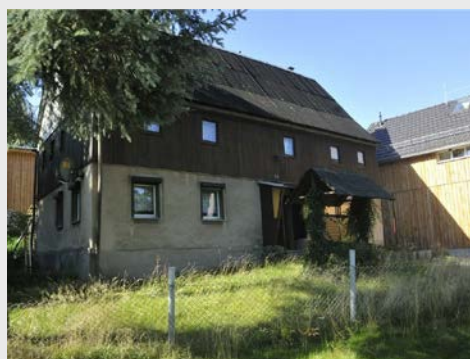
In dem Haus an der Talstraße 52 in Rugiswalde wohnt keiner mehr. Hier sollen bald Autos parken. © Dirk Zschiedrich
